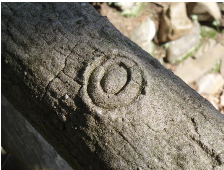
Cementrustieke brug bij Jachtslot Mookerheide te Mook. Detail van de boomschors met takaanzet, 2010 - foto SB4/Eric Blok
