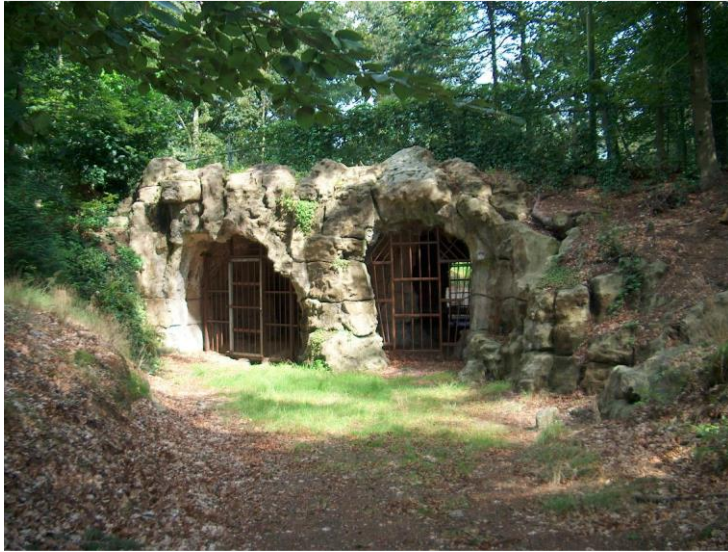
Tunnel op buitenplaats Hydepark te Doorn - foto SB4/Eric Blok
