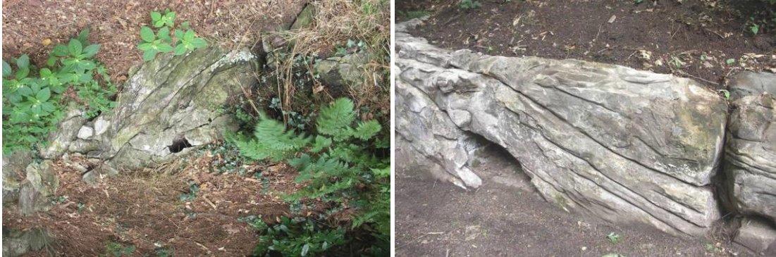
Plaatselijk herstel, mortel achteraf op kleur gebracht met pigmenten en bindmiddel – foto's RCE
